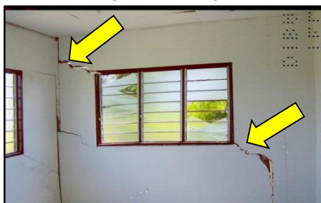
Kampung Paloh, Hutan Kandis, Arau - Rumah yang Mengalami Keretakan Dinding (Tahun 2015)
