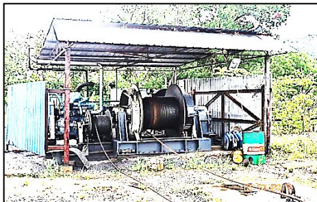
Limbungan Perlis Marine Engineering Sdn. Bhd. - Penggunaan Winch Untuk Menarik Cradle (13.10.2016)
